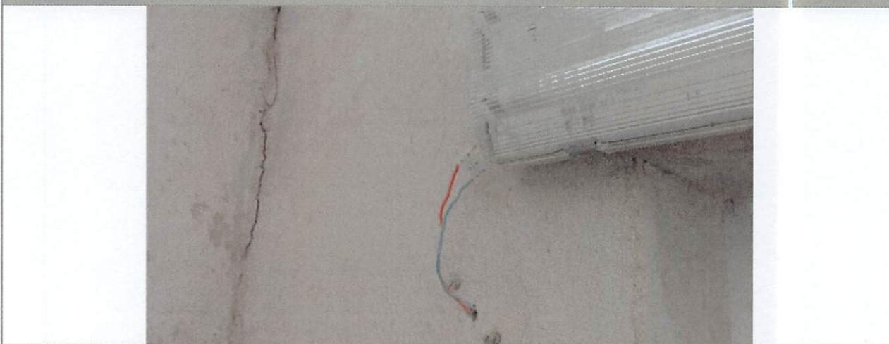
Description : Au moins un CONDUCTEUR nu et/ou au moins une partie accessible est alimenté sous une tension > 25 V a.c. ou > 60 V d.c. ou est alimenté par une source autre que TBTS.
